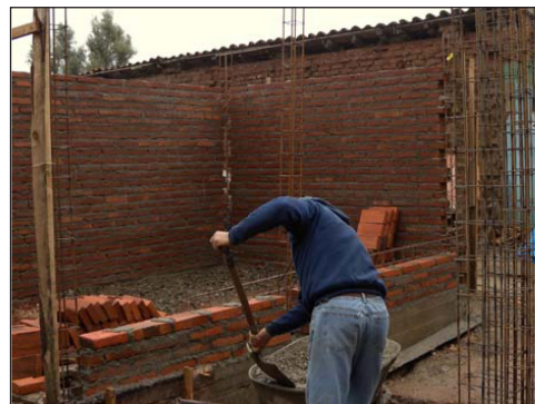
Wall construction (photos: S. Brzev).
