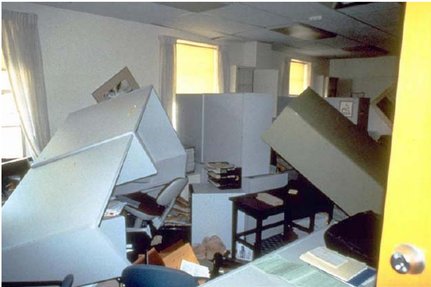
VA Sepulveda - NS Damage
